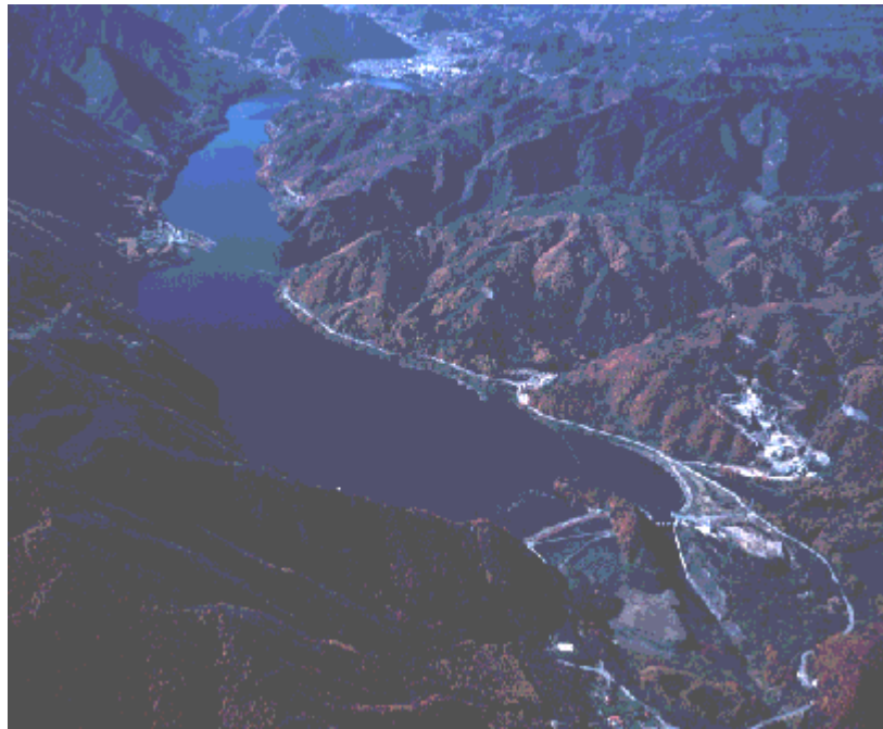
Fig-8 Makio Dam
