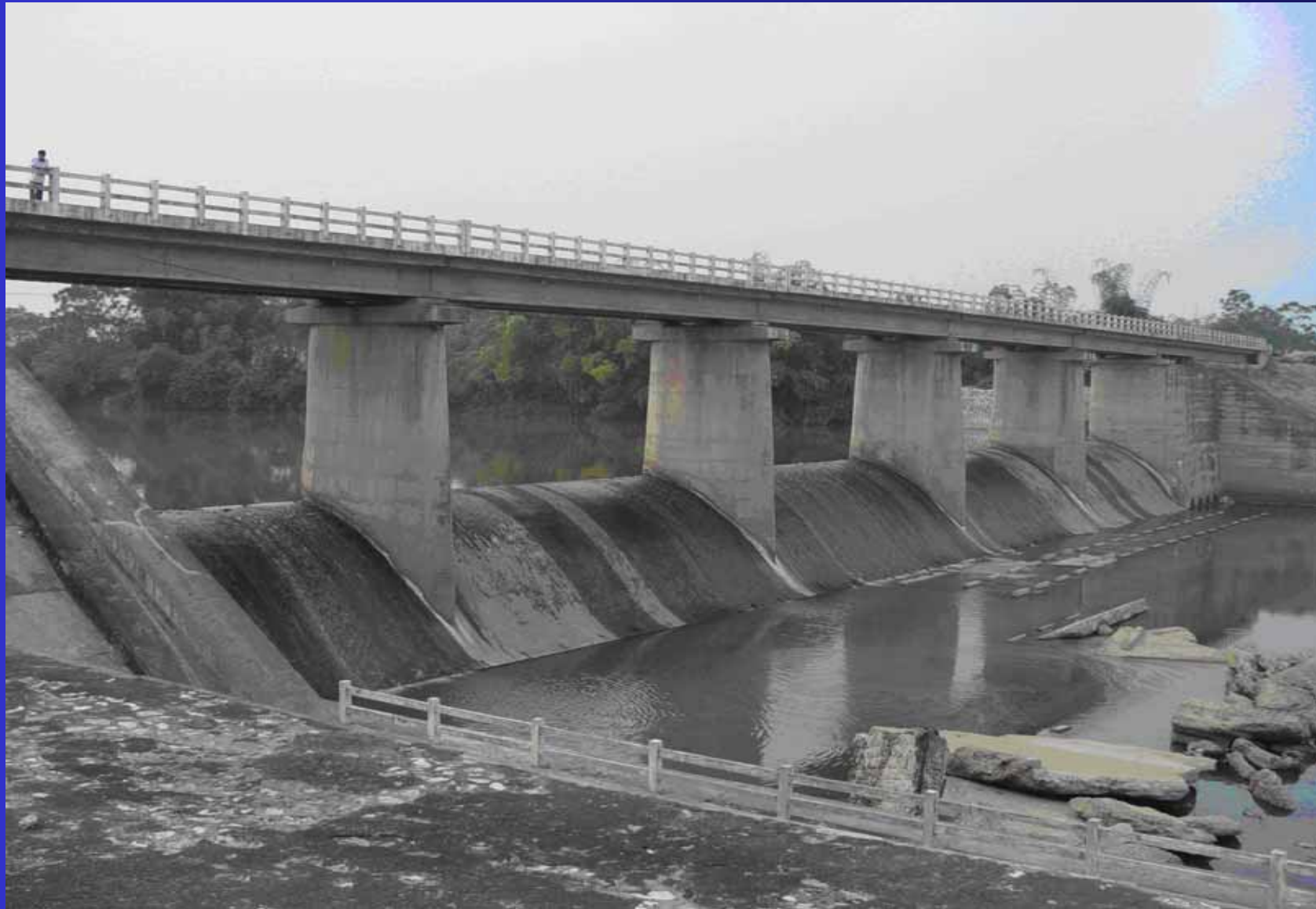
Thac Huong dam
