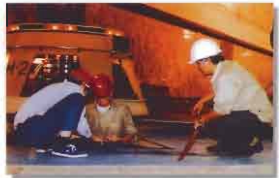
Sửa chữa máy phát điện Repair of Electric Generator
