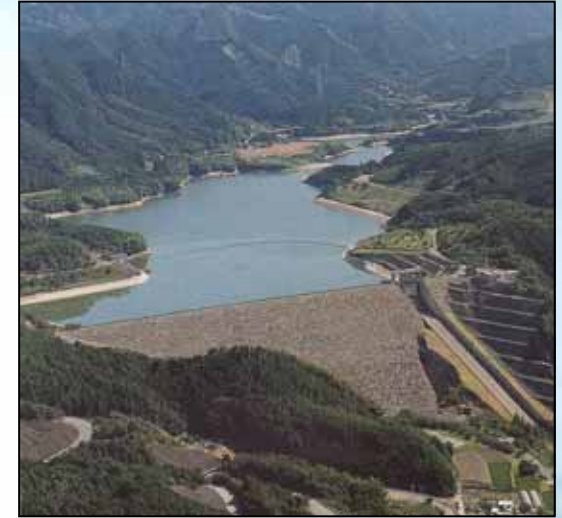
Terauci Dam (Rock Fill Dam)
