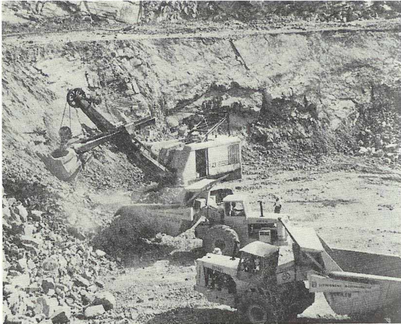
牧尾ダム工事で活躍すパワーショベル（上）とダンプホーラー（下）
