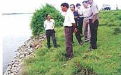
Kè Công Chùa huyện Giao Thủy (Nam Định) bị sạt lở
