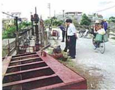
Duy tu bảo dưỡng công Phú Lý ( Hà Nam ) trước mùa mưa bão
