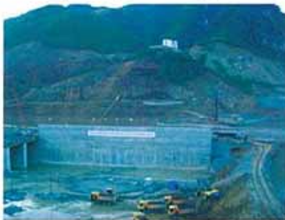
Công trường thi công Công trình thủy điện Sơn La
