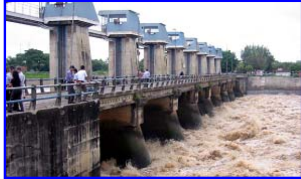
New Lengkong Barrage
